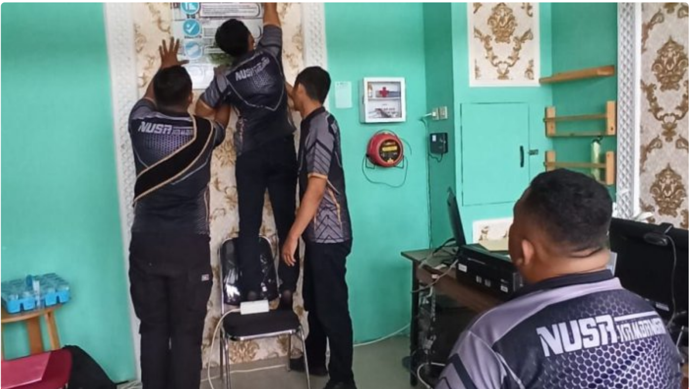
Kabapas dan Staff Renovasi Ruang Baladewa
